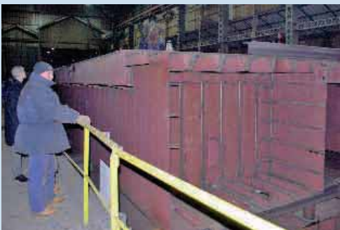
D. R. Dans la cale sèche du chantier naval de la Socarenam les éléments de la future passerelle du port de Boulogne représentent 400 tonnes d'acier.
